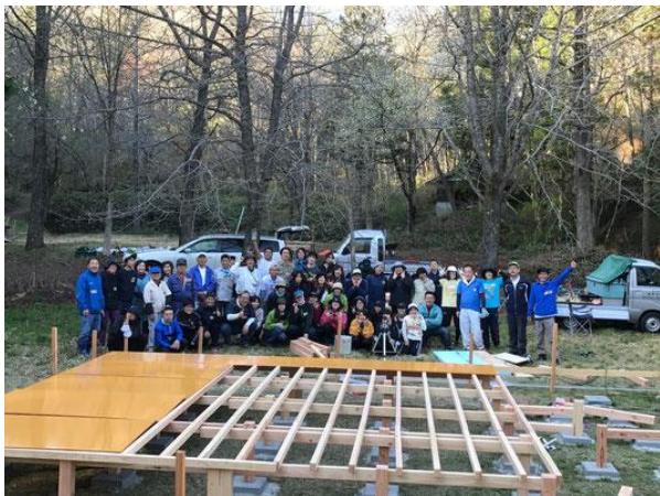
テントの床貼り
