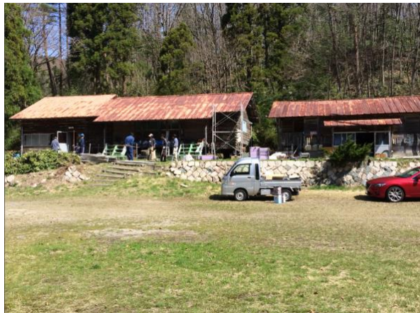
管理棟・宿泊棟 ペンキ塗り BEFORE
