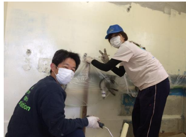
シャワールーム・トイレのペンキ塗り
